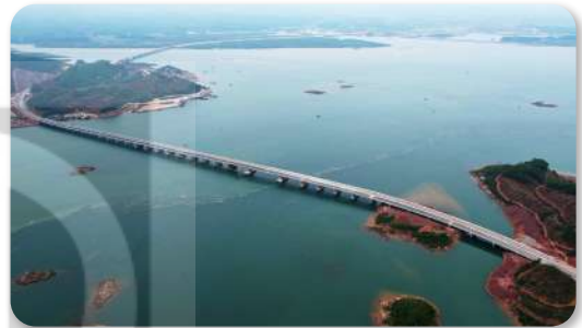
Hình 12.6. Cầu Vân Tiên dài 1.515m, là cầu lớn nhất trong tổng số 32 cầu trên toàn tuyến cao tốc đường bộ Vân Đồn – Móng Cái, cũng là cây cầu dài nhất tỉnh Quảng Ninh hiện nay
