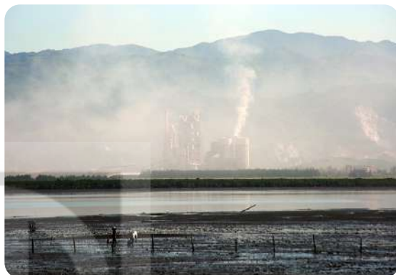
Hình 13.5. Khói, bụi từ Nhà máy xi măng Hạ Long (xã Thống Nhất, Hạ Long) bay phủ một khu vực rộng lớn (ảnh chụp và đăng trên báo Quảng Ninh điện tử ngày 27/4/2016)
